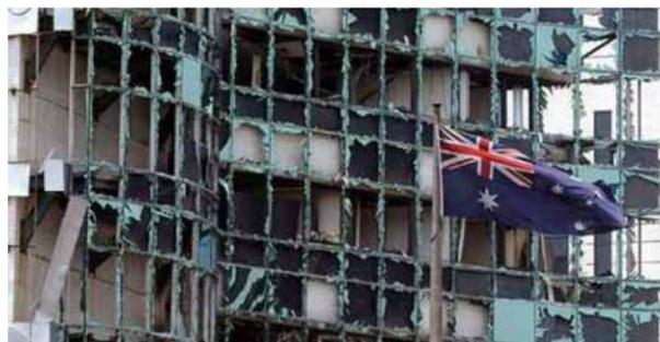
**Рис. 2.** Разрушения остекления под действием ВУВ в условиях городской застройки
